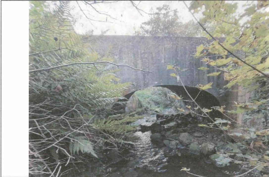
Parement amont de l'ouvrage d'art
