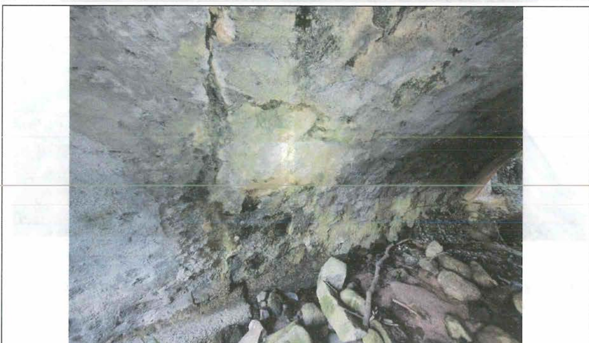
Voute maçonnée rejointoyée
