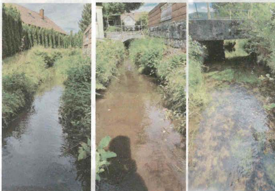
Vues sur le bras droit à l'aval de l'ouvrage 218P03
