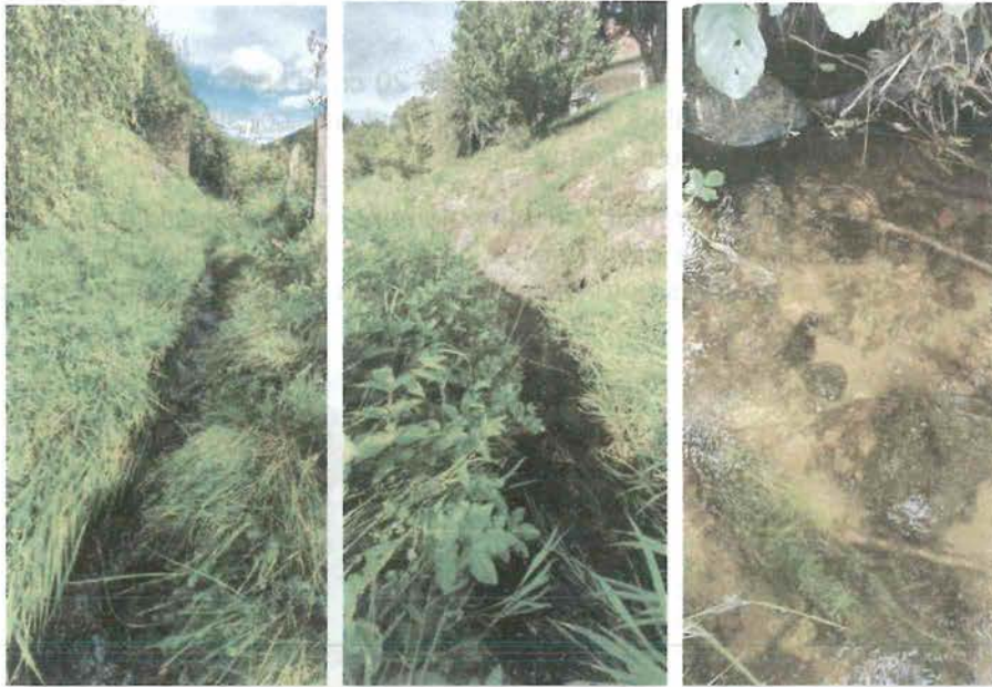
Vues sur le bras gauche à l'aval de l'ouvrage 218P03
