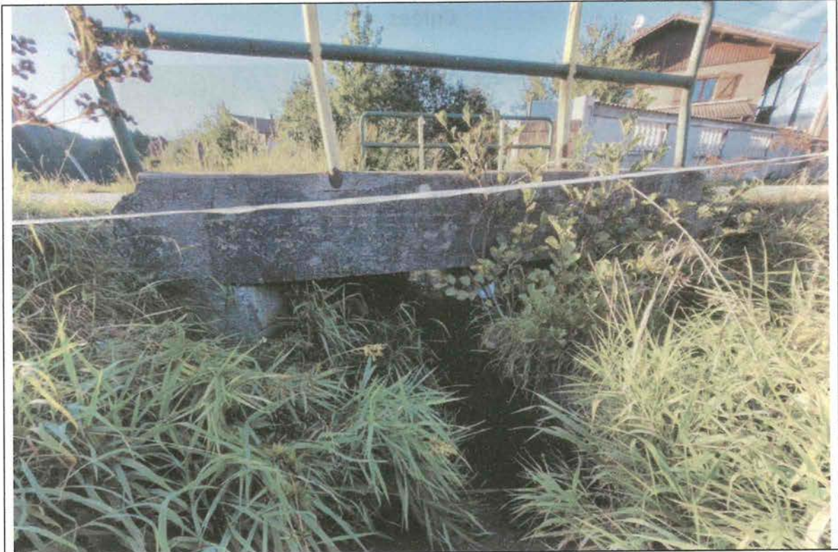
Parement est de l'ouvrage d'art
