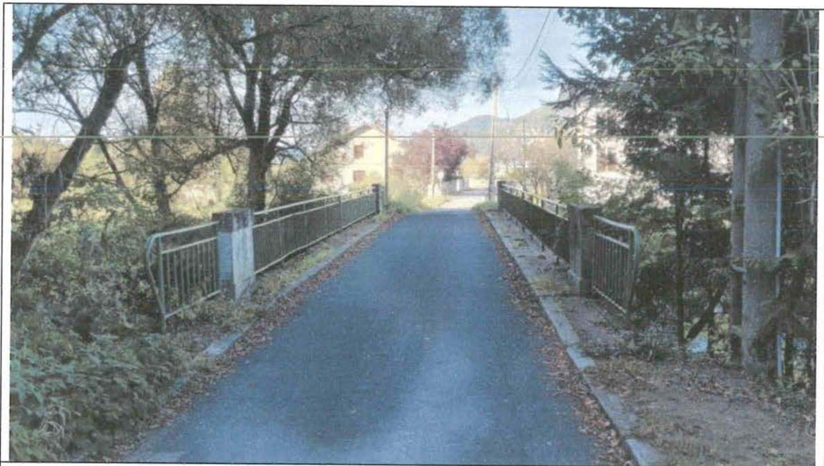
Vue supérieure de l'ouvrage d'art et des garde-corps
