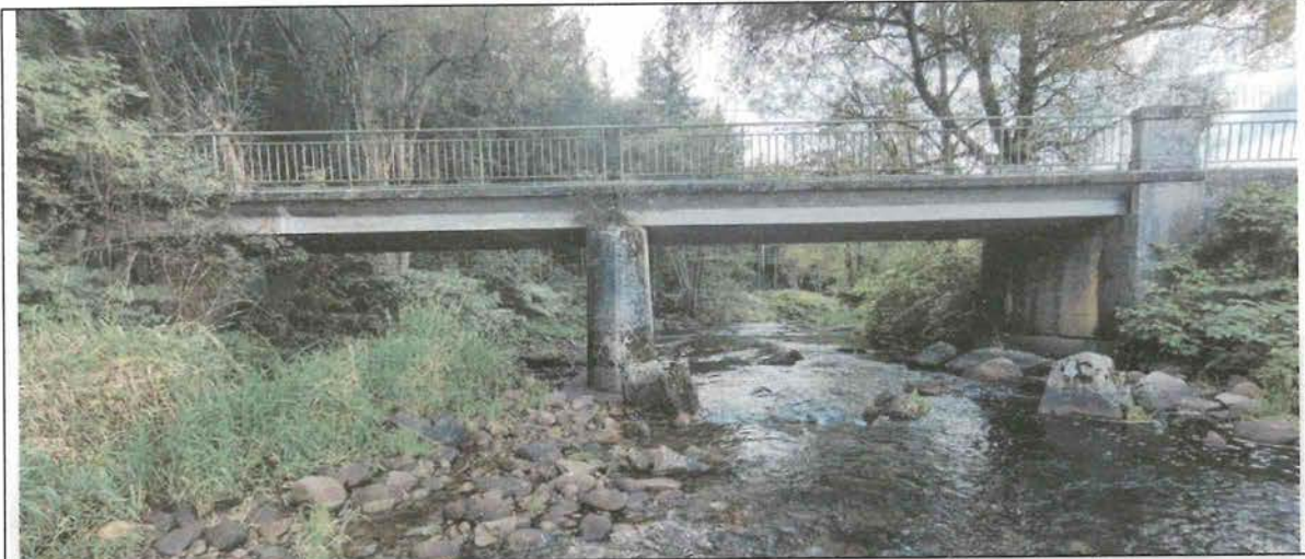
Vue depuis l'amont de l'ouvrage d'art
