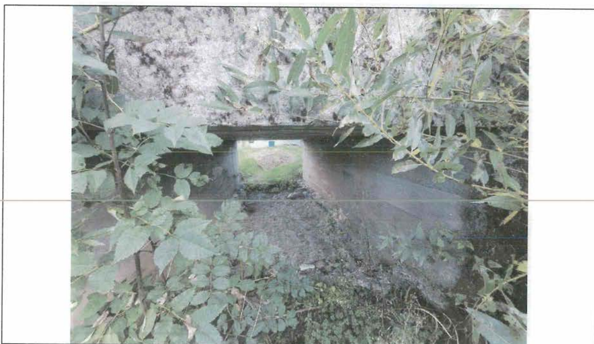
Parement ouest de l'ouvrage d'art
