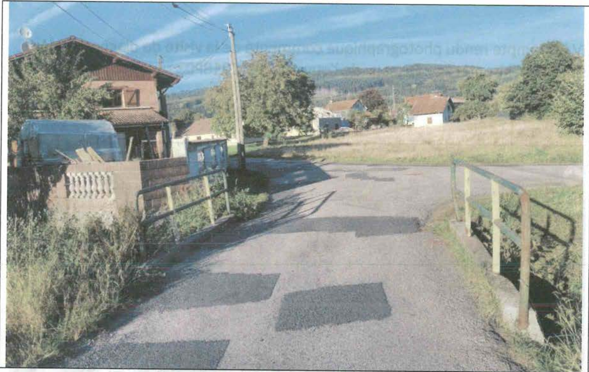
Vue supérieure de l'ouvrage d'art et des garde-corps
