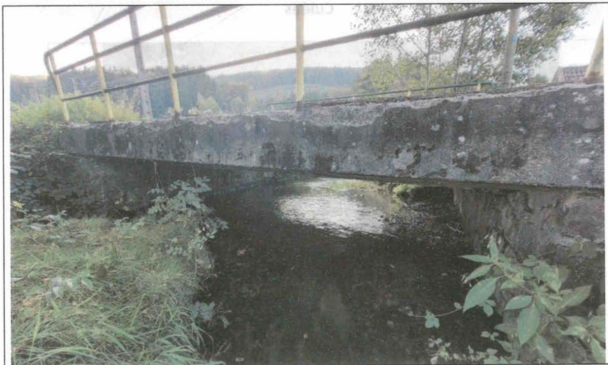
Parement est de l'ouvrage d'art
