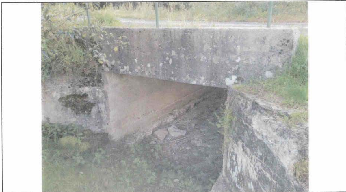
Parement est de l'ouvrage d'art
